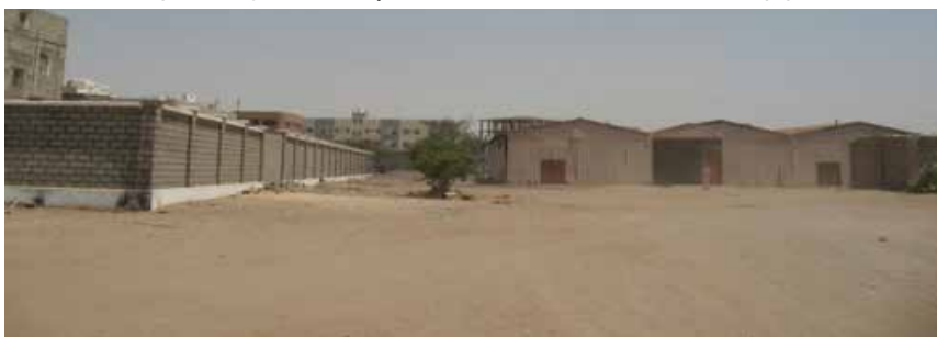
Figura 3 - Este é o mesmo armazenamento de munição. Está localizado n um prédio de luz desprotegido, com considerável desenvolvimento urbano fora do complexo, incluindo um novo prédio de apartamentos a 100m.
