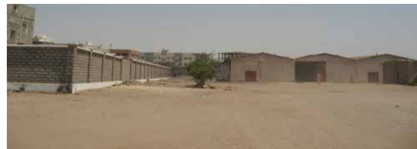
Image 3 - Le même dépôt de munitions. Il s'agit d'une construction légère non protégée, avec un développement urbain considérable à l'extérieur du site, dont un immeuble résidentiel neuf dans un périmètre de 100 mètres.
